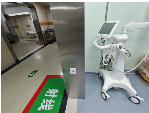
患者防护门防夹感应装置
